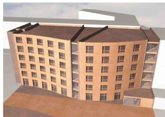
Abb. 1: Weltweit erstes 6-geschossiges Wohngebäude in kompletter Holztragwerkskonstruktion: Realisierung 2007, Entwurf und Konzept: Kerbl Architekten, Berlin
